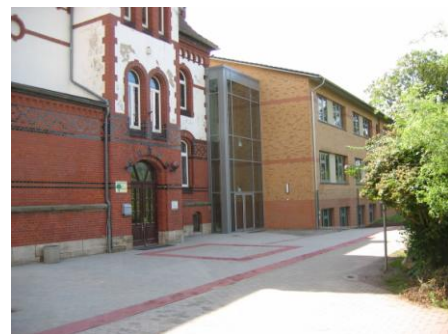
Stallgebäude des Klosterhofes
